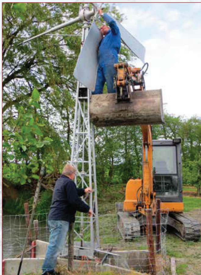
Willem de Boer bevestigt de wieken aan de molen, Nico Bijvoet houdt het mechanisme in toom, 1 juni 2015.
