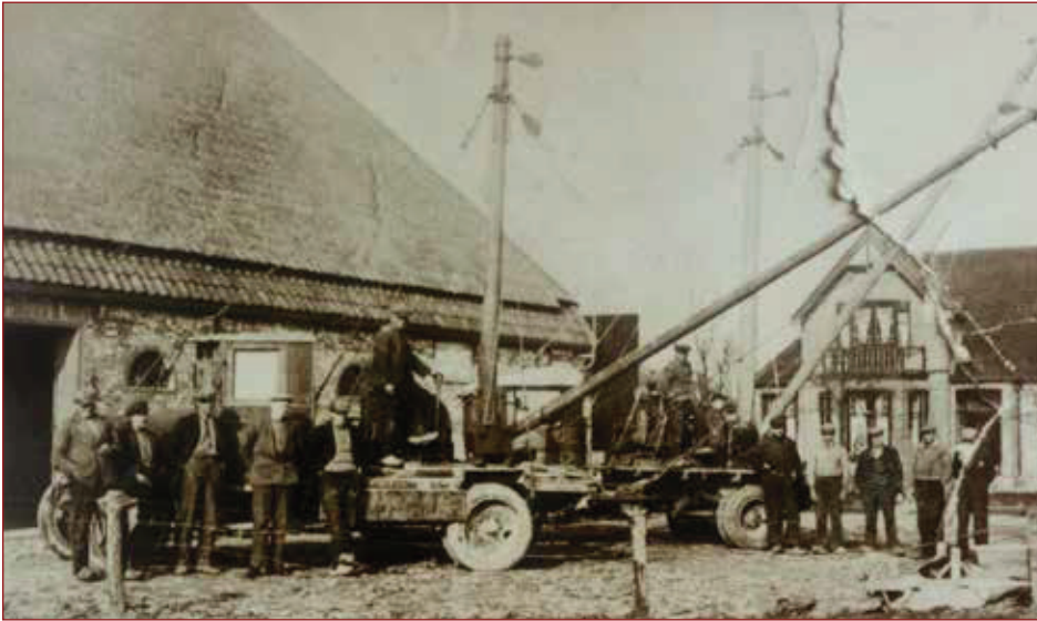
Garage Roemer met materieel en verschillende werklieden, onder meer Jan Manshanden en Ferry Varga. Foto van voor de oorlog.
